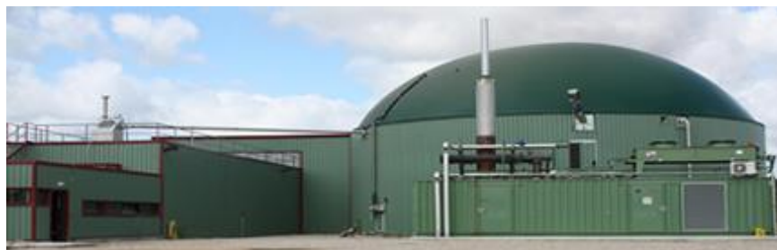
Figura 5.21: Digestor de Dos Fases y motor. Fuente: Proyecto PROBIOGÁS (2007-2012).
